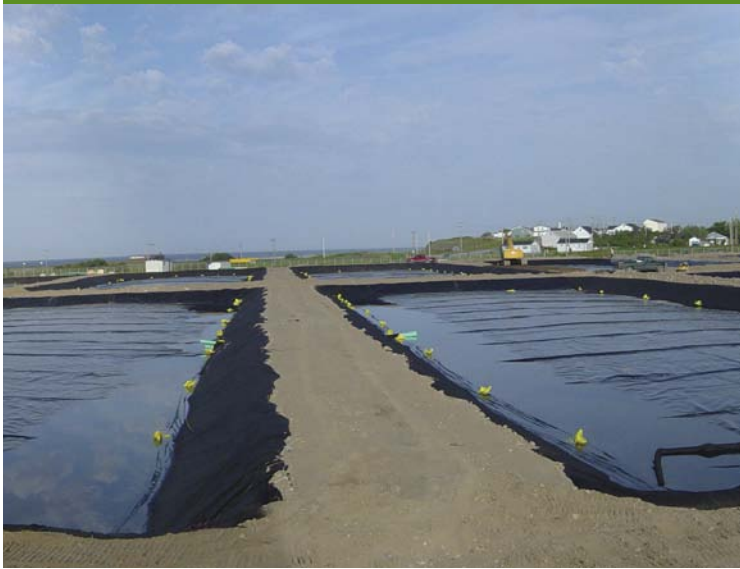
Des lits biologiques de traitement des eaux usées sont préparés dans le cadre d'un système sans produits chimiques, lesquels accueilleront les eaux usées de Stephenville (photo : Ville de Stephenville).
