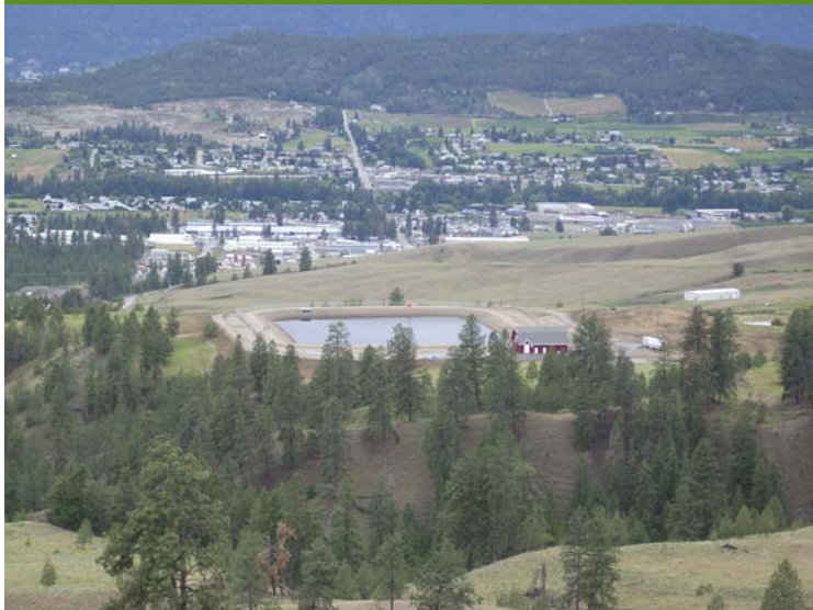
La micro-installation de production hydroélectrique de Lake Country créera une rupture de la pression à son entrée dans le réservoir, produisant simultanément de l'électricité (photo : District de Lake Country).
